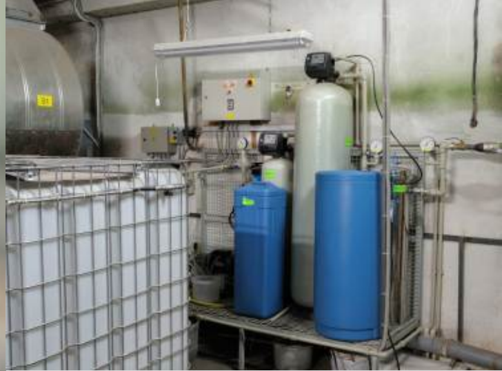
Станция очистки сточных вод
